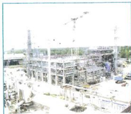
Строительство установки производства серы на Мозырском НПЗ
