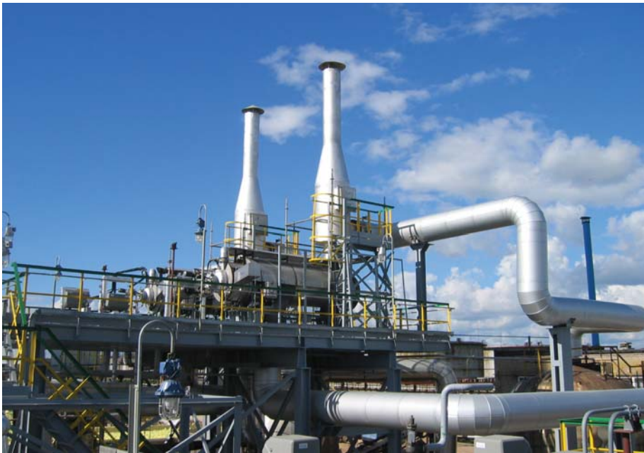
«Мажейкю Нарта» — проект реконструкции четырех блоков двух установок
